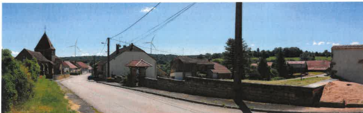
Photomontage page 145, pièce 4, annexe 2, volet paysager du dossier d'enquête publique, église de Chauvirey-le-Châtel
